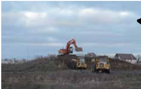
Om du kör förbi industriområdet på E22 kan du se högar som belastar ytorna där huset och rampen ska vara
